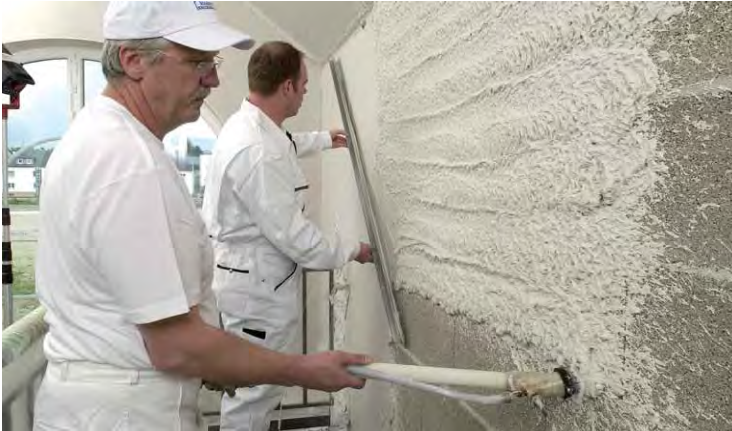
Schaefer Krusemark Mörtel wird aufgebracht Schaefer Krusemark mortar being applied
