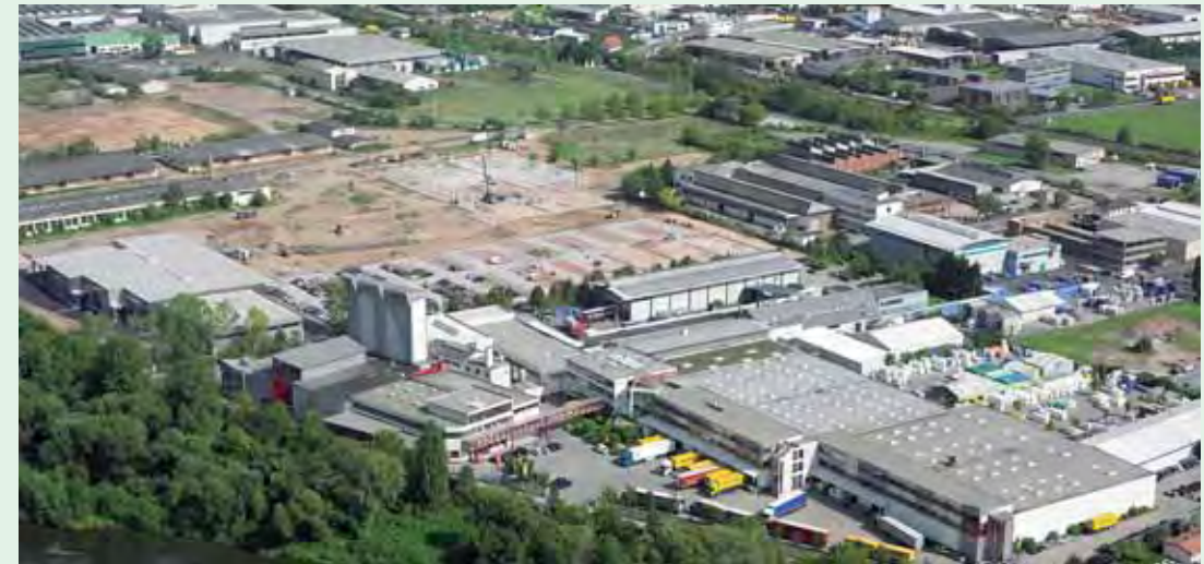
Firmengelände der Meffert AG in Bad Kreuznach Meffert AG in Bad Kreuznach company site
