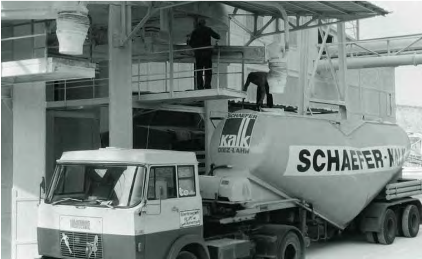
Feinkalkloseverladung im Werk Hahnstätten, 1971 Fine quicklime bulk loading at the Hahnstätten plant, 1971
