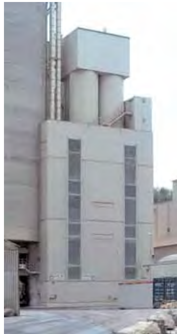
Außenansicht Hydratanlage, 2010 Exterior view hydrated lime unit, 2010
