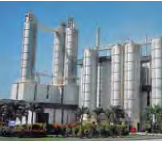
PCC-Anlage im Werk Kuala Ketil, 2005 PCC unit at the Kuala Ketil plant, 2005
