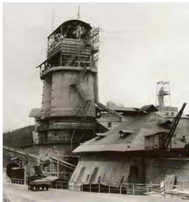
Gasöfen und Kleiner Ringofen in Hahnstätten, 1954 Gas shaft kilns and small ring kiln in Hahnstätten, 1954
