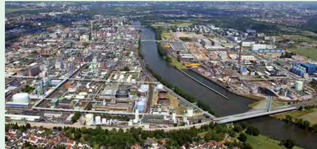
Industriepark Höchst, Frankfurt am Main Industrial Park Höchst, Frankfurt am Main
