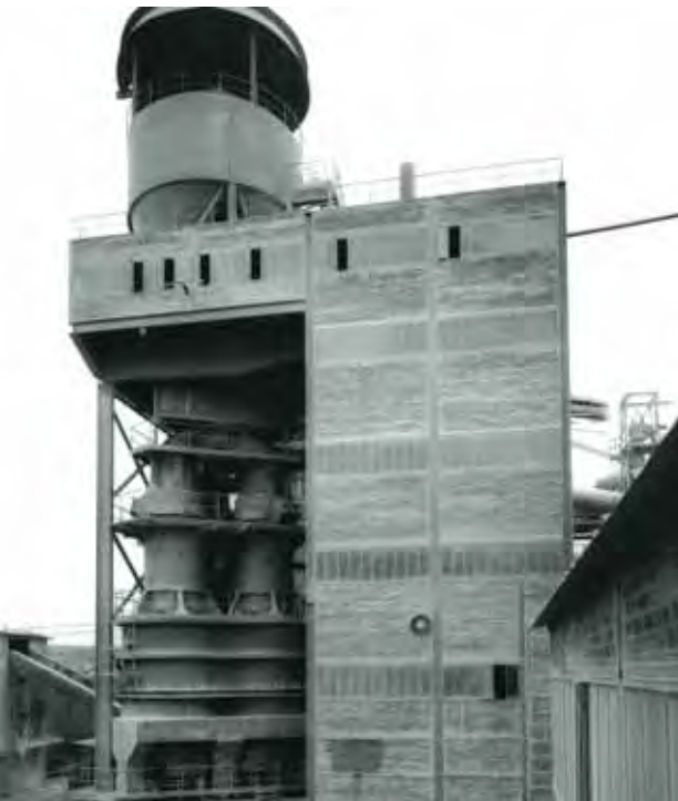
Ofen 2 im Werk Hahnstätten, 1969 Kiln 2 at the Hahnstätten plant, 1969
