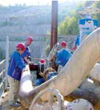
Arbeit an der Wasserhaltung im Steinbruch Hahnstätten, 2005 Working on the water drainage at the Hahnstätten quarry, 2005
