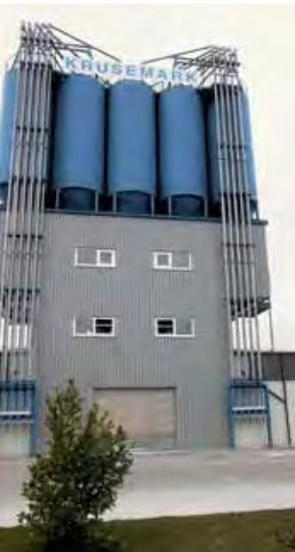
Werk trockenmörtel-anlage Krusemark Mühlheim, 2007 Dry-mortar plant unit Krusemark Mühlheim, 2007
