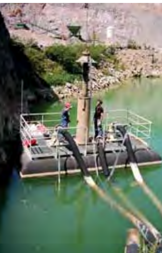
Reparatur der Wasserhaltungspumpen im Steinbruch Hahnstätten Repairing the drainage pumps at the Hahnstätten quarry
