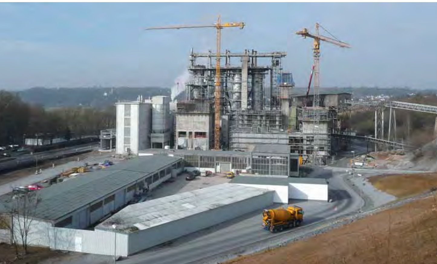
Werkserweiterung in Steeden, 2009 Plant extension in Steeden, 2009
