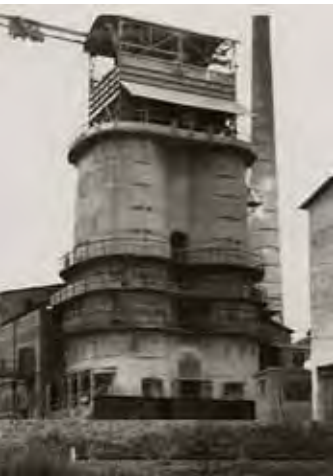
Gasöfen im Werk Hahnstätten, 1953 Gas-fired kilns at the Hahnstätten plant, 1953
