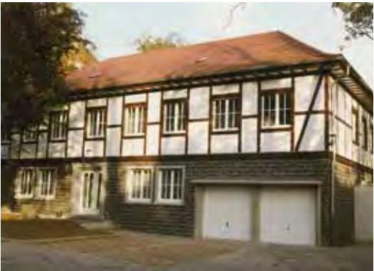
Erweiterung der Verwaltung in Diez, 1994 Administration extension in Diez, 1994
